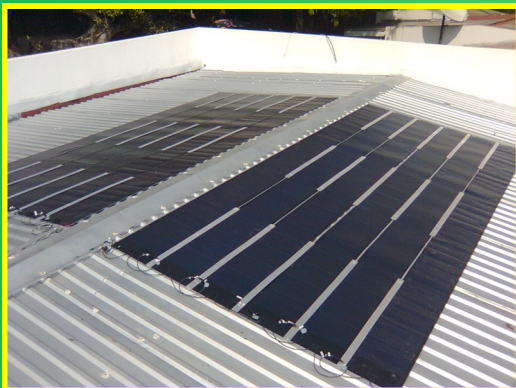
Sistema de generación eléctrica con conexión a red 1.63 KWp con paneles Amorfos , Casa recreacional Lago de Coatepeque
